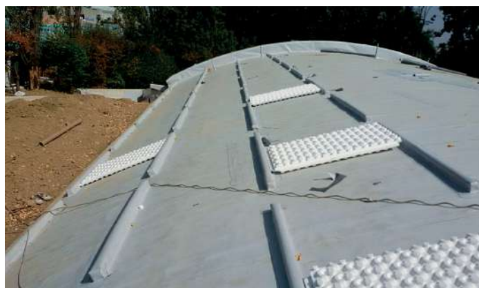
Colmo copertura ove previsto sistema con MediDrain MD 40 fino a 9° di inclinazione.
