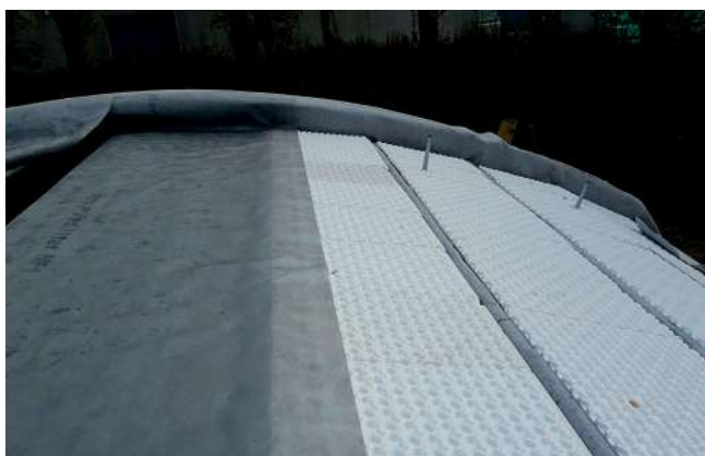
Linee rompitratta e Medi Term MT 80 su tratto inclinato da 9° a 32°.
